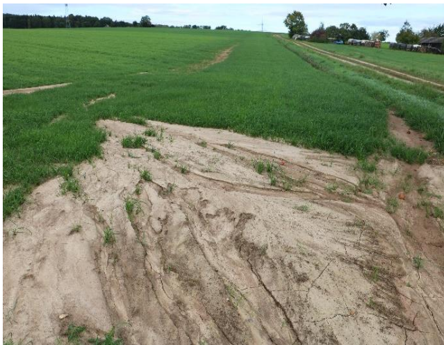
Abb. 2 Spuren heftiger Erosion in Landberger Gemeinde
